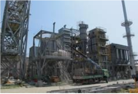
INTEC Sistema de Lecho Fluidizado, Taiwain, en construcción, Octubre 2012
